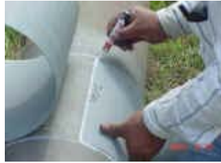
Paso 2 Marcar y Colocar la Manga
