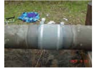
Paso 4 Instalación Completa
